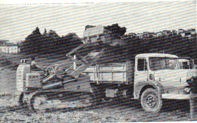
Travaux d'aménagements des terrains de sports. En fond le Manoir de Capelé et les grands arbres des allées d'accès vers la piscine et les tennis.
