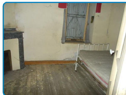
1er étage Chambre 2
