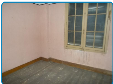
1er étage Chambre 1
