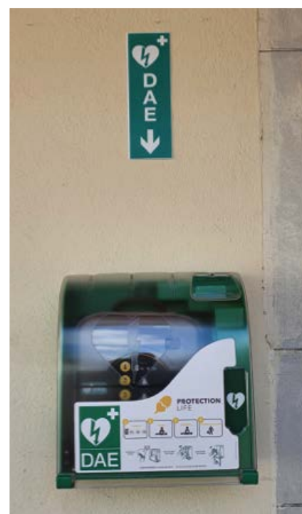
Mise en place d'un défibrillateur sur la façade de la mairie
